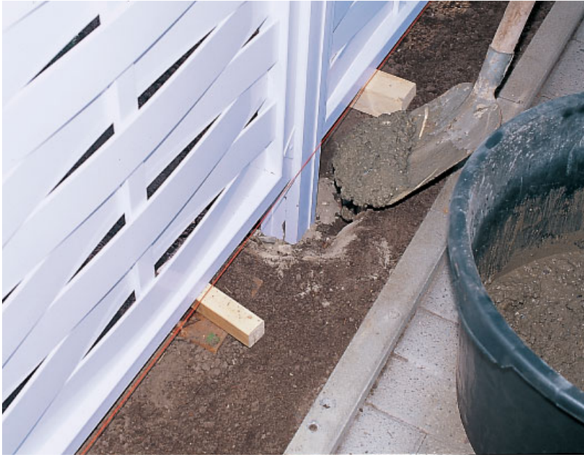
Pfosten direkt ins Erdreich einbetonieren...
