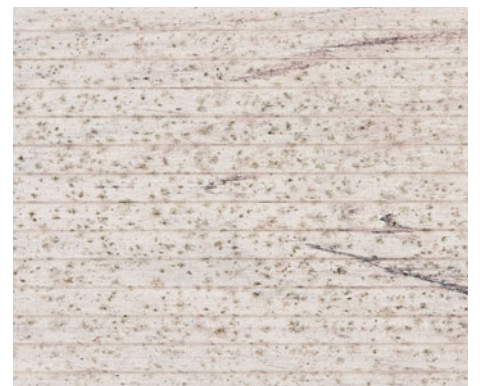
Stockflecken/Schimmel auf der Oberfläche
